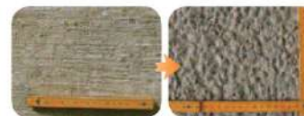
骨材露出の状況（左 施工前、右 施工後）
