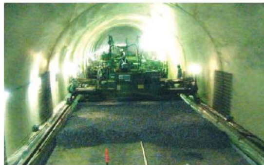
1車線施工 → 2車線を一度に施工
