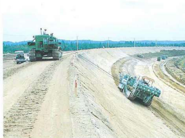
▲ウィンチトラクタと法面用スタビライザ
