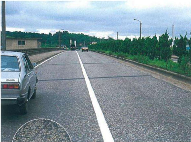
寒冷地道路の表層に用いられたロードグース 円内はその路面(供用3ヵ年経過)
