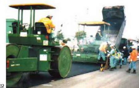
アスファルト舗装の施工状況
