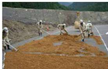
吸着材敷均し状況
