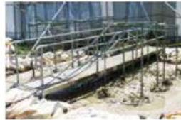
スパージング施工状況
