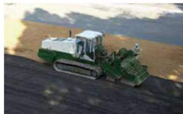
吸着材 攪拌・混合状況
