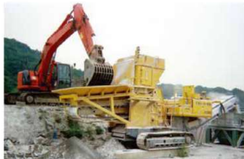
添加材の添加・混合状況
