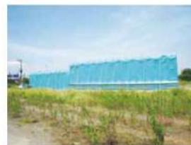
テント設置状況
